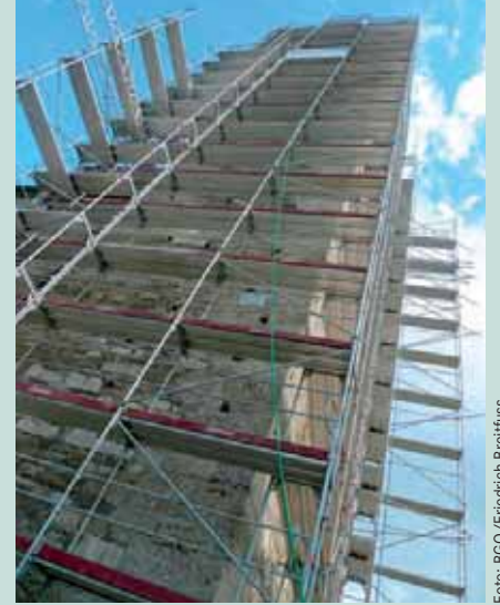
Nordturm des Doms während der Restaurierung 2011
