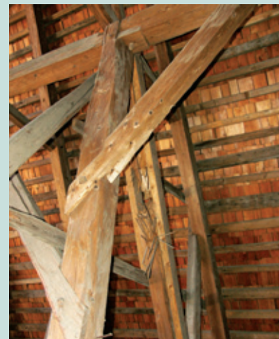
Möllbrücke, Pfarrkirche, Schäden im Dachwerk und Blick auf den Westgiebel.
