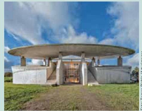
Raimund Abraham, Haus für Musiker – sog. Abraham Bau, Raketenstation Hombroich
