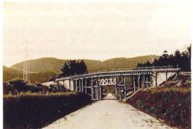
Abb. 22: Eines der vielen Infrastrukturprojekte im Zusammenhang mit dem Bahnbau: Bahnunterführung beim vlg. Ladinig (Chronik der VS Untermitterdorf).
