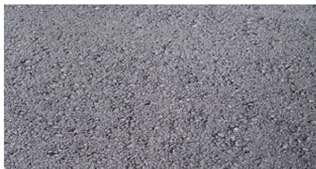
Fahrbahn | gefärbter Asphalt
