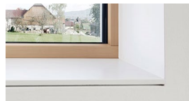
Fensterbank | Kunststein 15mm Weiss matt, FH, mit Schattenfuge, allg. innen
