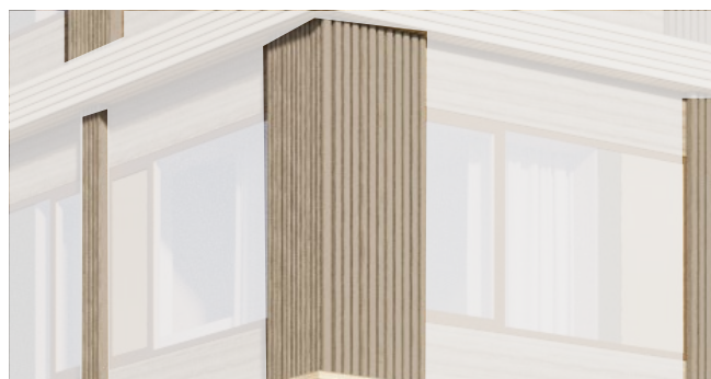
Vertikale Fassade | Schalung vertikal Lattung
