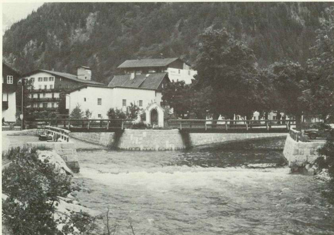
Abb. 5 Im Siedlungsgebiet ist die harte Verbauung richtig.
