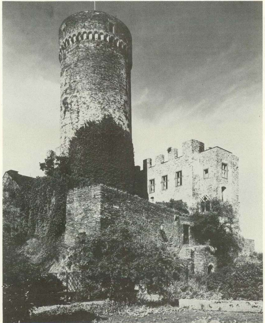
Burg Pyrmont. Ansicht von Südwesten
