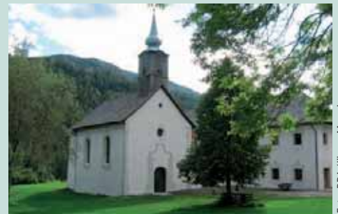
Innerteuchen, „Klösterle“ nach der Außenrestaurierung
