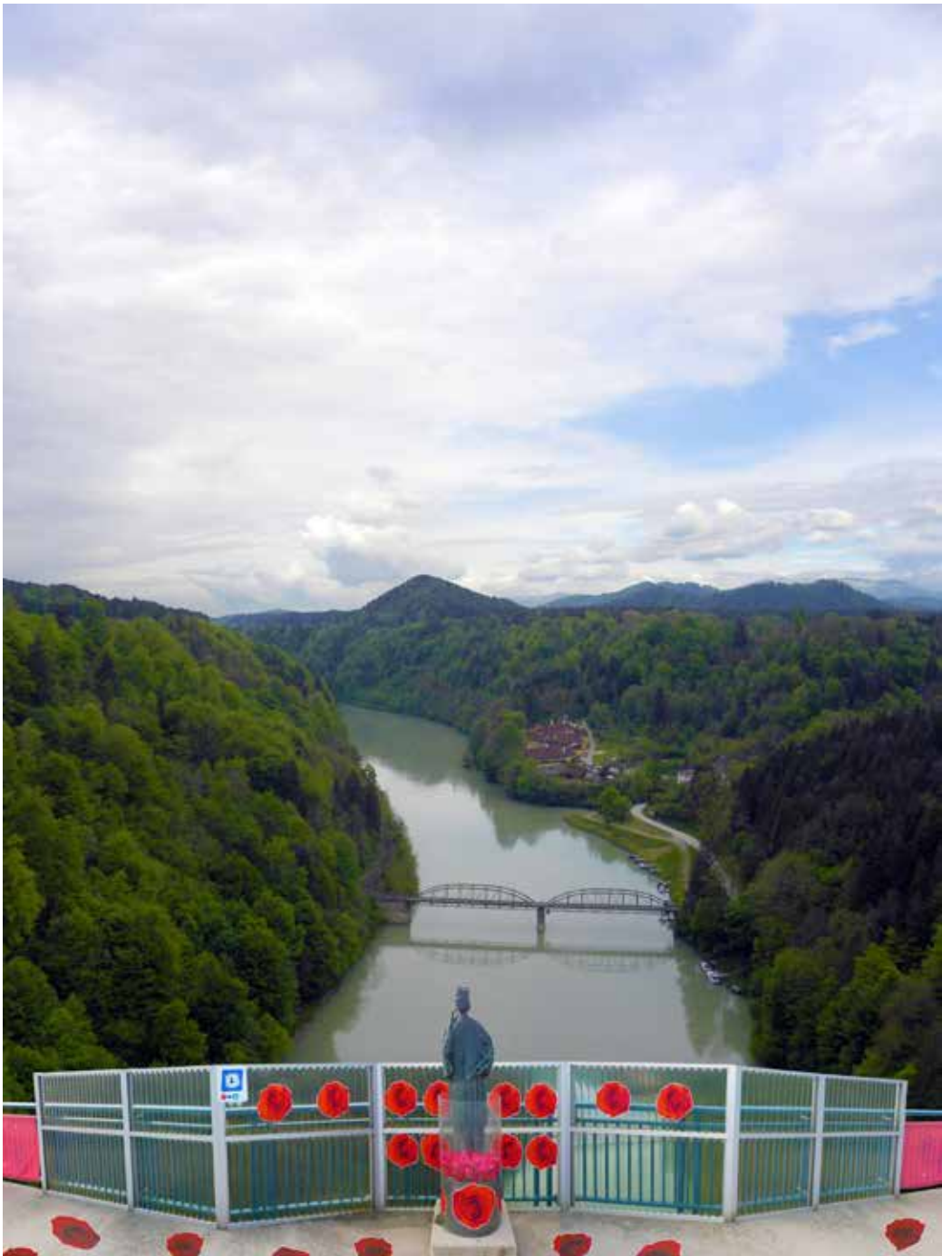
BRÜCKEN BAUEN/GRADIMO MOSTOVE. Foto: Gerhard Leeb
