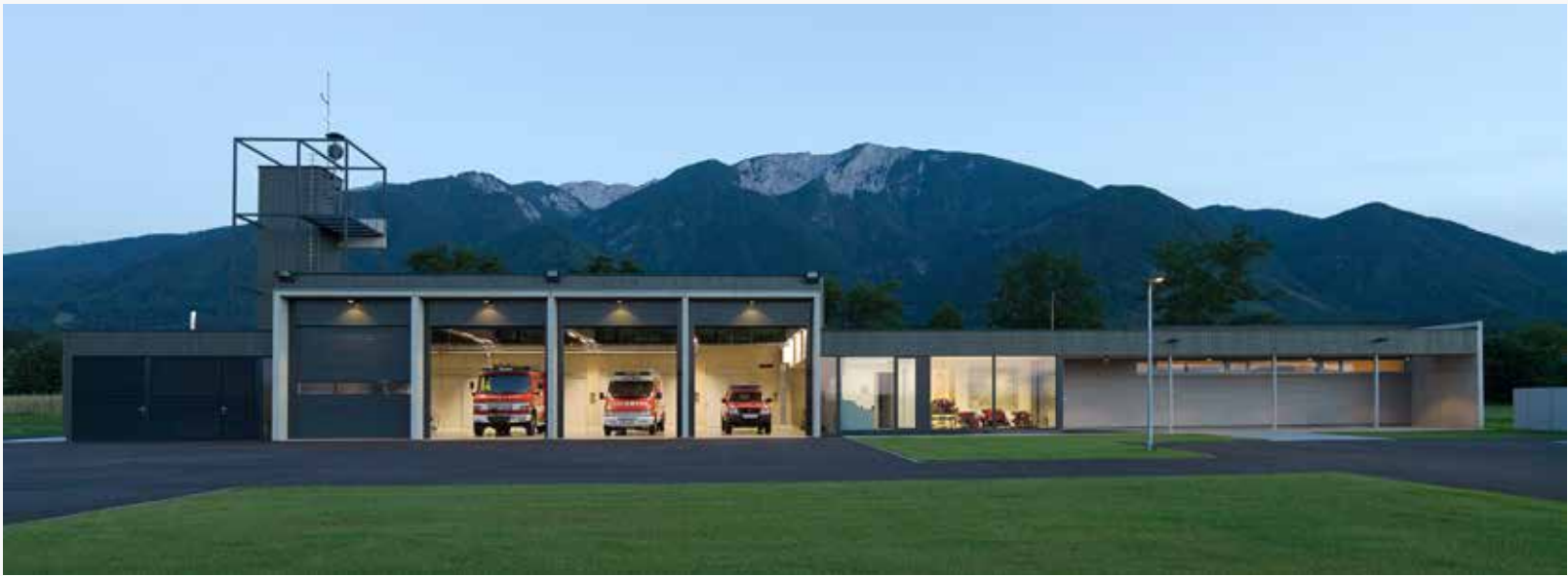
Neubau Feuerwehrhaus Feistritz ob Bleiburg, Architekt Reinhold Wetschko. Foto: Gisela Erlacher
