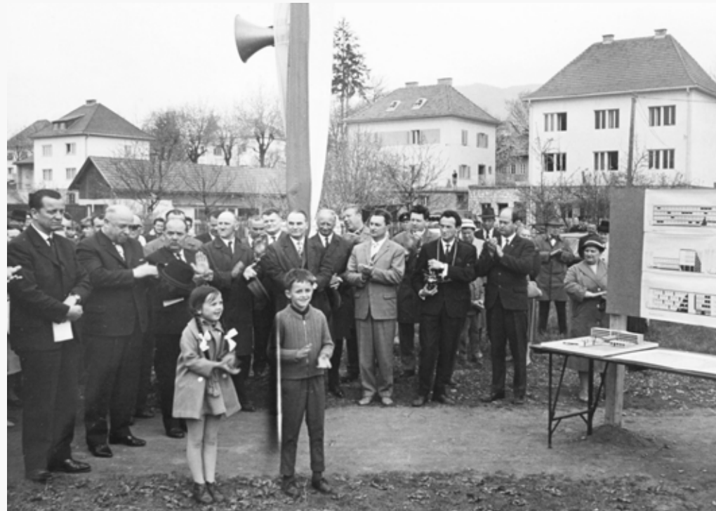
Der Spatenstich zum Bau der Hauptschule Villach-Lind. Foto: Wallisch/Fotoarchiv Öffentlichkeitsarbeit/Museum-Archiv der Stadt Villach
