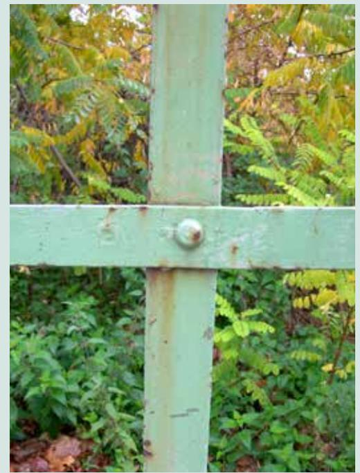
Sterbende Kärntner Eisenbrücke: Fußgängersteg in Annenheim. Detail einer zeittypischen Nietverbindung. Foto: G. Klever
